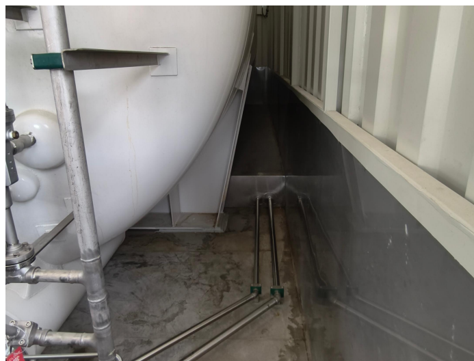
LNG 储罐围堰
